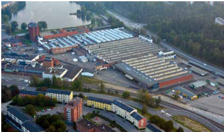
Ambitionen är att automatisk vibrationsövervakning ska införas på Scanias alla produktionsanläggningar - i Luleå, Södertälje (på bilden) och Oskarshamn – på alla befintliga maskiner där man bedömer att det behövs.
