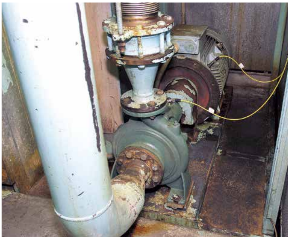
Vibrationsövervakningsenheten har bland annat indikerat ett fel på en pump för en tvättanläggning för rening av motorblock.
